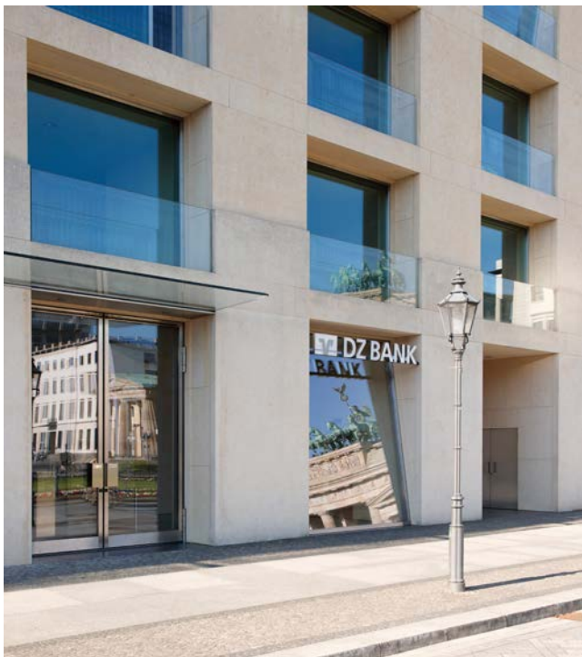
Büro des DGRV im DZ Bank-Gebäude in Berlin
