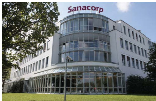
Sanacorp Hauptverwaltung Planegg
